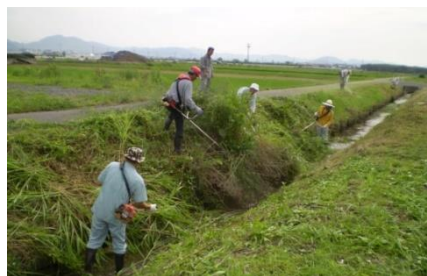
水路の草刈り、泥上げ
