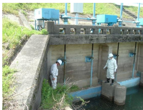
頭首工取水ゲート施設診断
