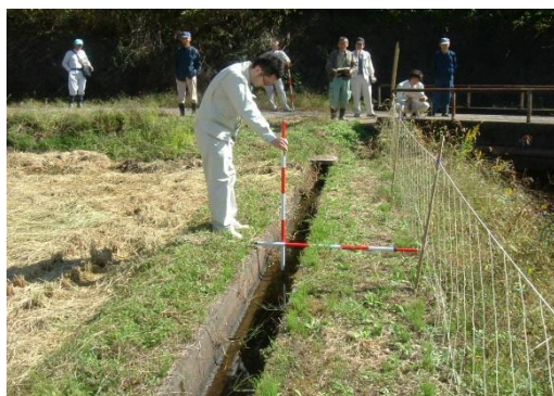
用排水路施設診断
