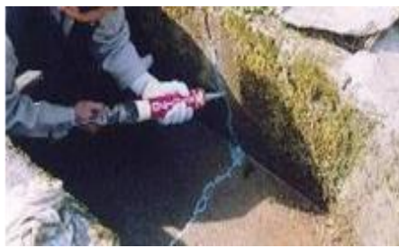
水路の軽微な補修
