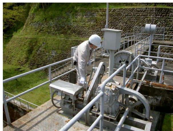
頭首工（土砂吐ゲート）の保守点検
