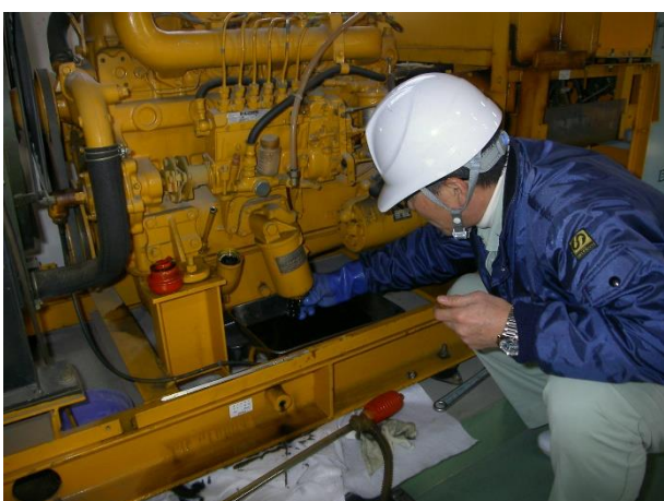
排水機場の自家発電用エンジンオイル交換
