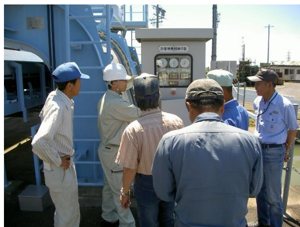
排水機場（除塵機）の操作指導
